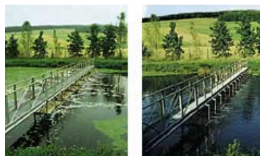
Station d'épuration avant
